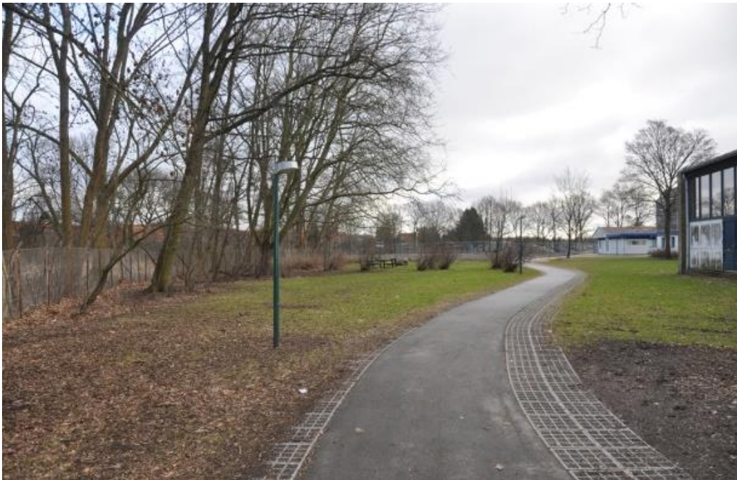
Figur 6. Prøvebelysning i Elverhøjparken med NYX monteret på eksisterende mast. Den lave mast giver desværre en dårlig realemæssighed i belysningen.
