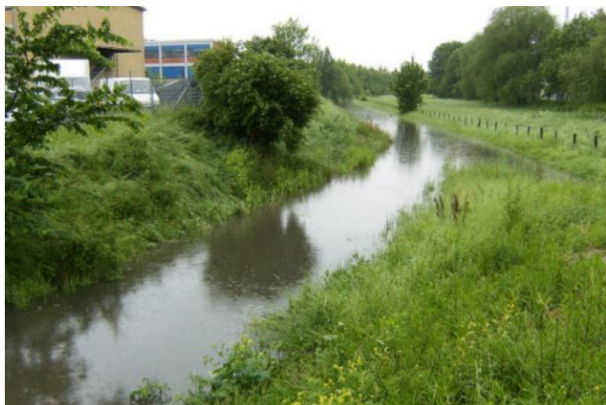
Figur 3: Foto af vandfyldt dobbeltprofil i Sømse Å ved Mileparken efter større regnhændelse.
