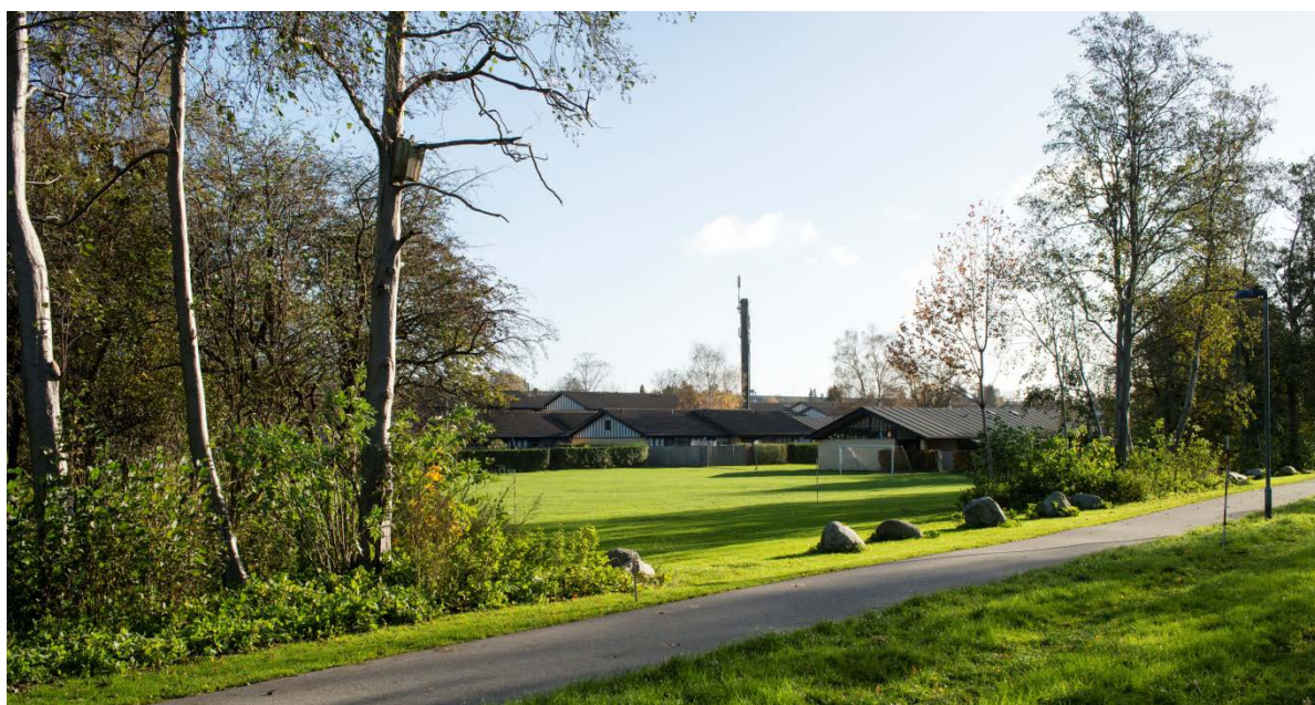
Figur 9-7 Fotostandpunkt 2 set mod sydøst i retning af Kagsåkollegiet.
