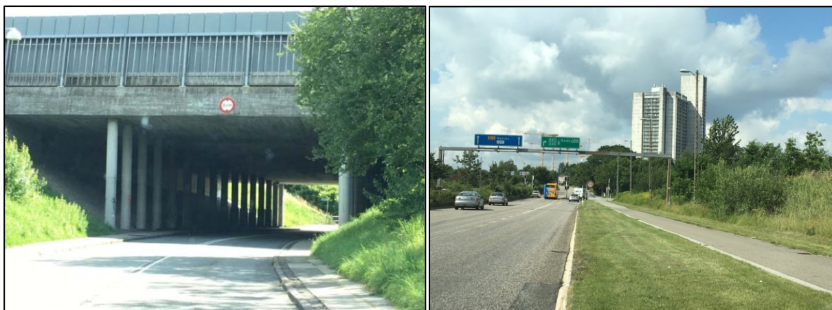
Figur 13-5 Til venstre: Adgangsvej 2, Kagsåvej øst, broen under Motorring 3 på Byværnsvej. Til højre: Adgangsvej 3 fra Gladsaxe Ringvej til projektområdet nord for motorvejtilkørsel mod Rødby.
