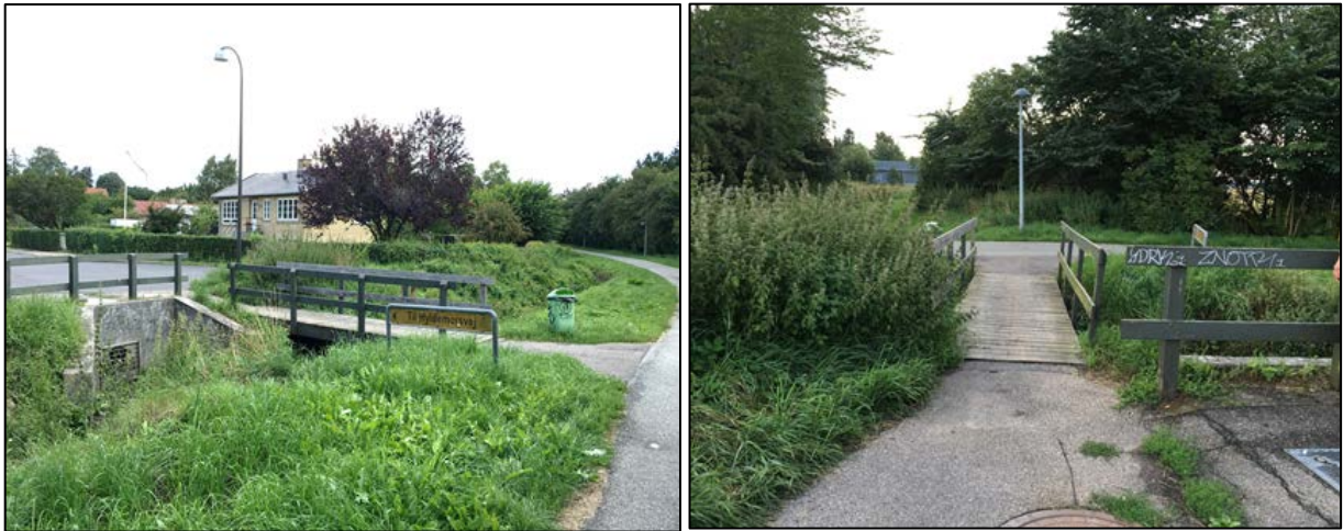
Figur 13-6 Træbro mellem Hyldemorsvej og projektområdet, som skal udvides og forstærkes.
