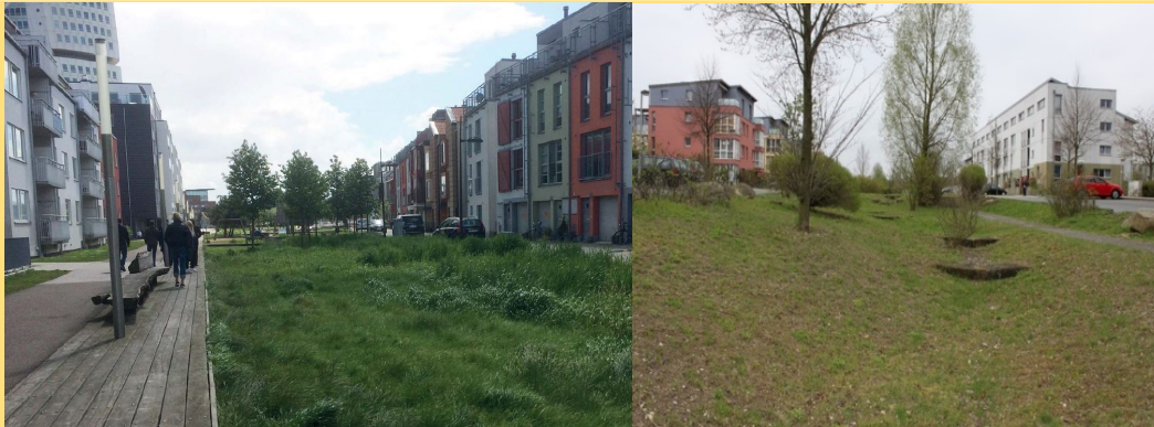
Transport af regnvand i nedsænket grønt bælte mellem bebyggelserne i Malmø.
