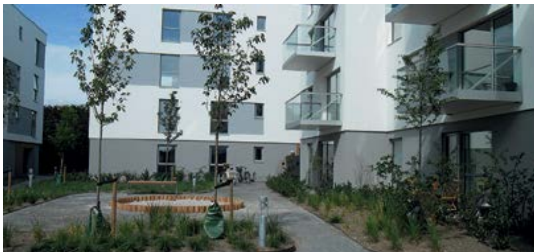
Et af de nye byggerier på Glødelampen
