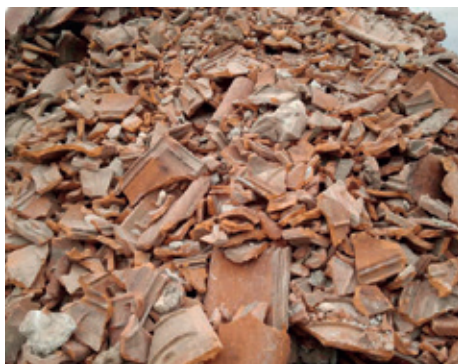
Tagsten fra nedrivning.
