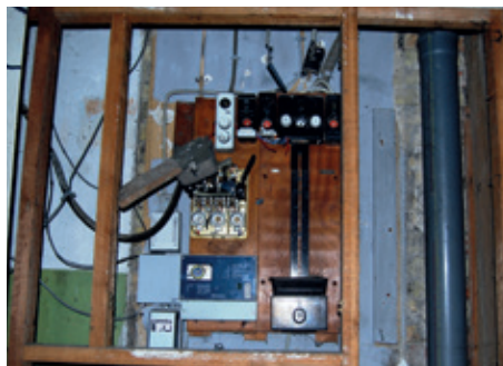
Eltavle kan indeholde relæer og andet elektrisk udstyr, der kan indeholde PCB og kviksløv.
