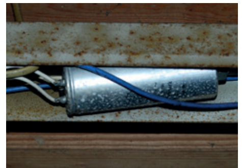
Ældre kondensatorer indeholder ofte PCB.
